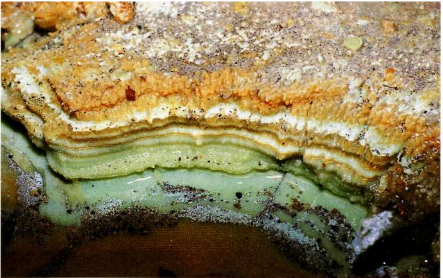
Abb. 4: Wechsellagerungen verschieden gefärbter Präzipitate am Boden des Stollens; Höhe des Anschnitts ca. 6 cm.
