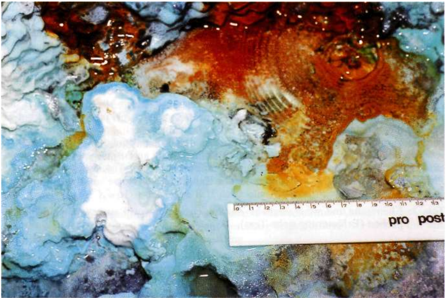
Abb. 3: Bildung verschieden gefärbter Schlammablagerungen aus Tropfwasser von First und Wand.
