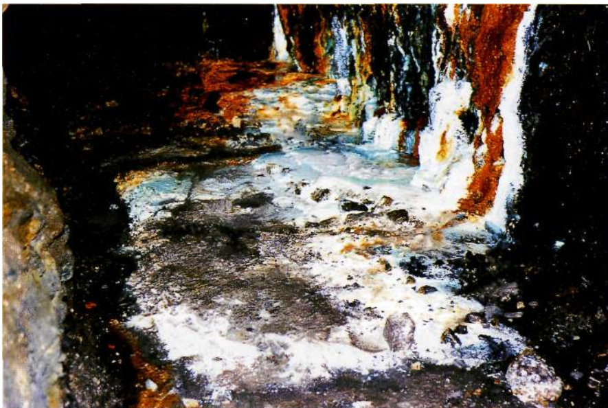
Abb. 2: Blick in den Untersuchungsstollen mit Sinterbildungen an der Wand und Schlammablagerungen am Boden (Bildbreite ca. 1,70 m).
